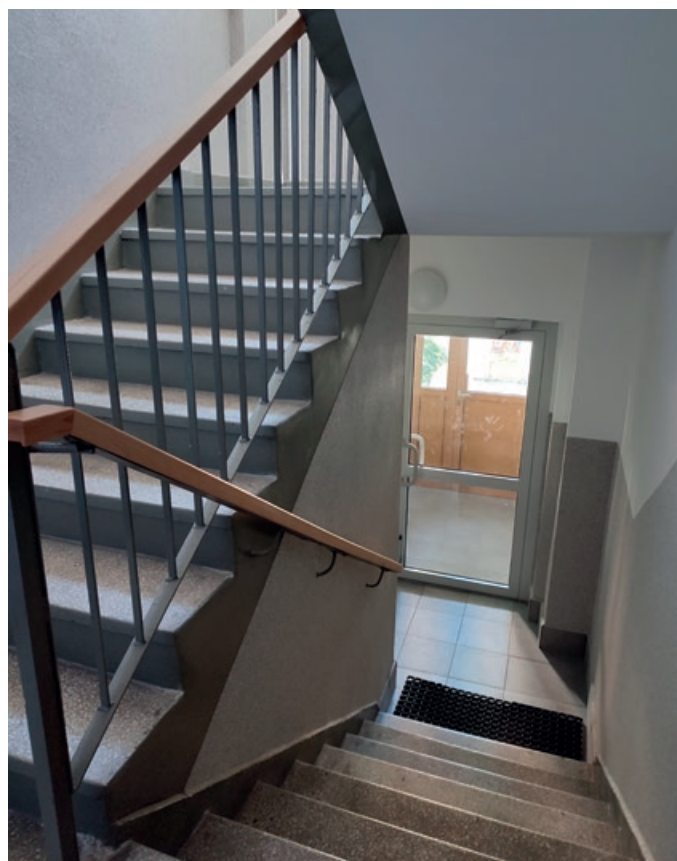
wyremontowana klatka schodowa
