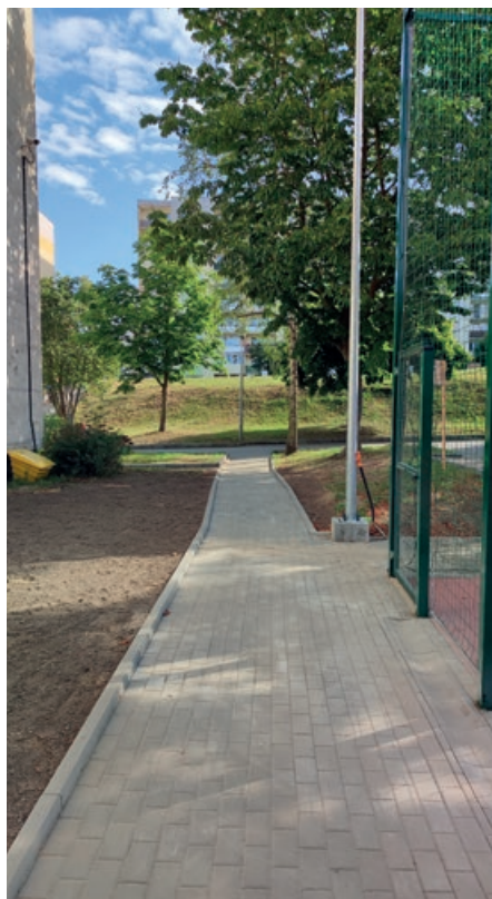
wyremontowany chodnik wokół boiska
