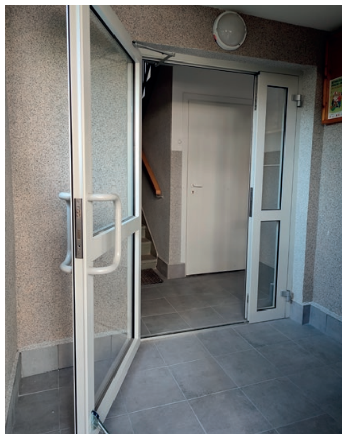
nowe drzwi wejściowe do klatki schodowej
