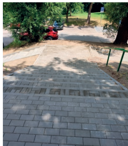
wyremontowane schody przy ul. Matuszewskiego 17-19
