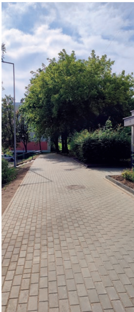
wyremontowane chodniki przy ul. Matuszewskiego 17-19
